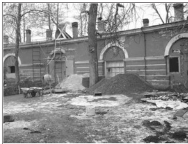
Рисунок 10. Здание Кронштадтской ветеринарной клиники до реконструкции
